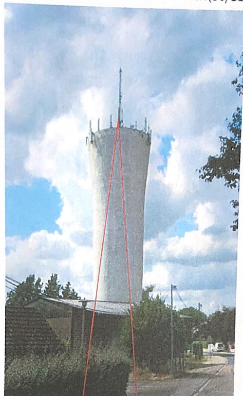
Photographie Vue de la Rue - Avant travaux (So, S1 & S2)
